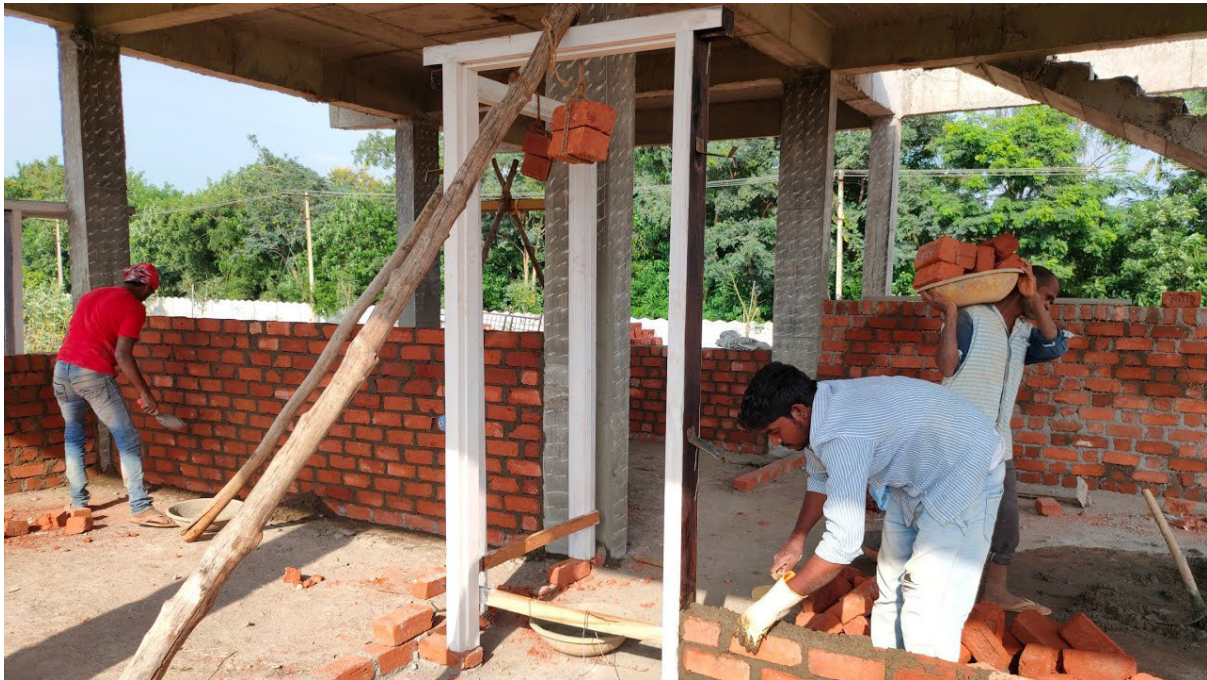
Fig. 5.3.1 Door Fixing
