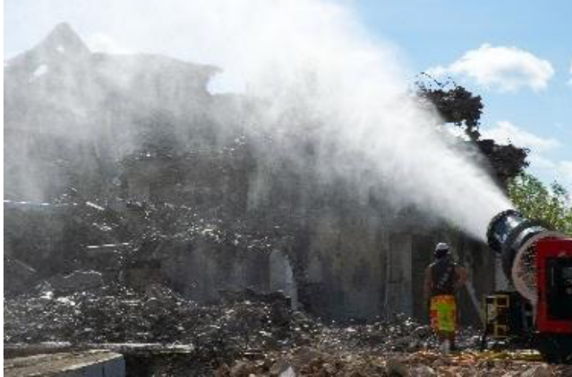
Fig. 5.3.10 Wetting Down Dust
