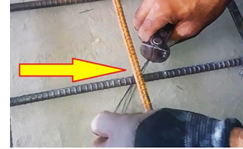
Fig. 3.1.3 Tying rebar
