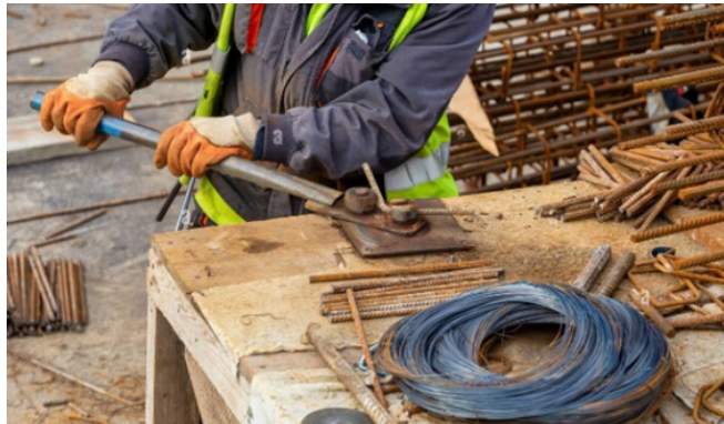
Fig. 4.1.8 Manual Bending
