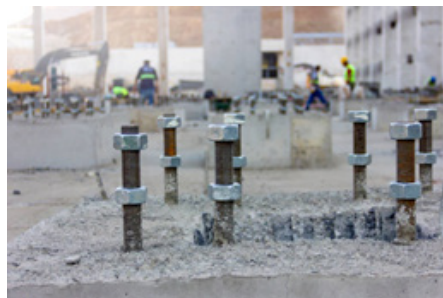
Fig. 4.1.1 Anchor Bolt
