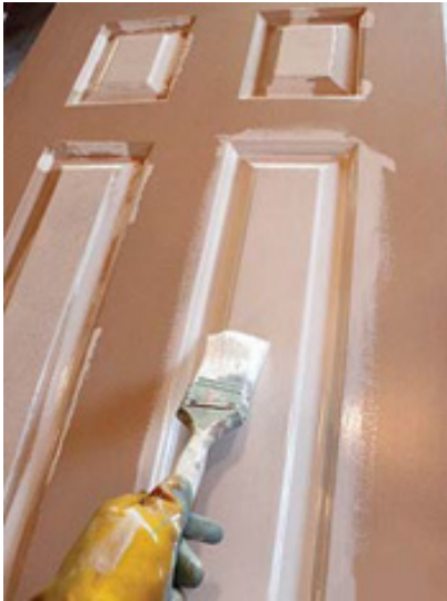
Fig 6.1.7 Applying primer
