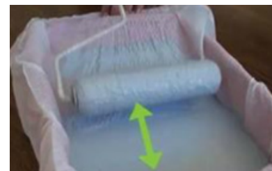
Fig 4.1.13 Moving roller in primer
