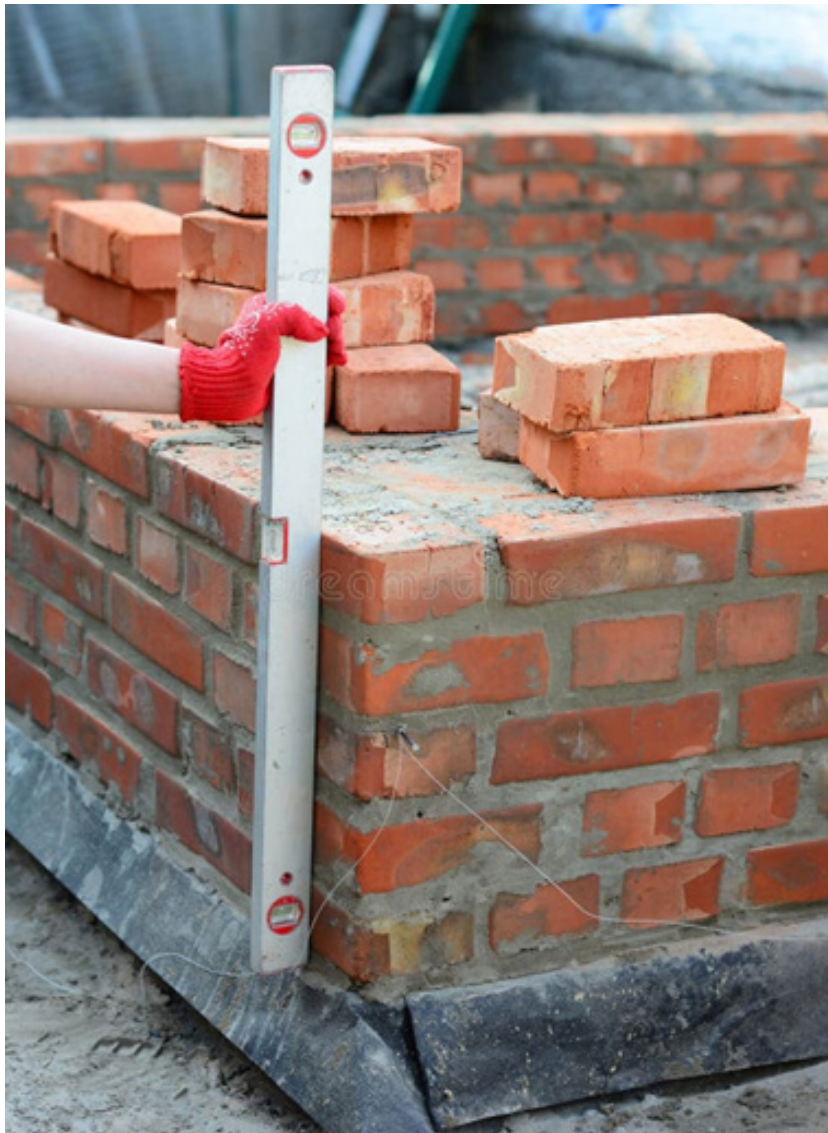
Fig. 3.1.4 Mason using spirit level
