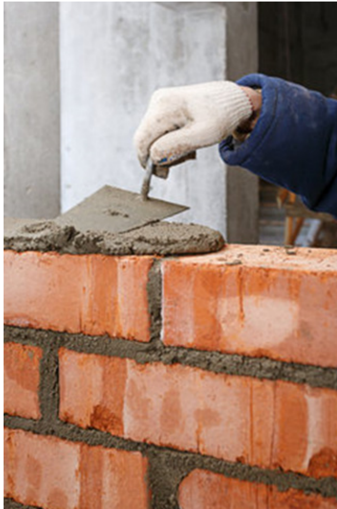
Fig. 3.1.2 Mason using trowel
