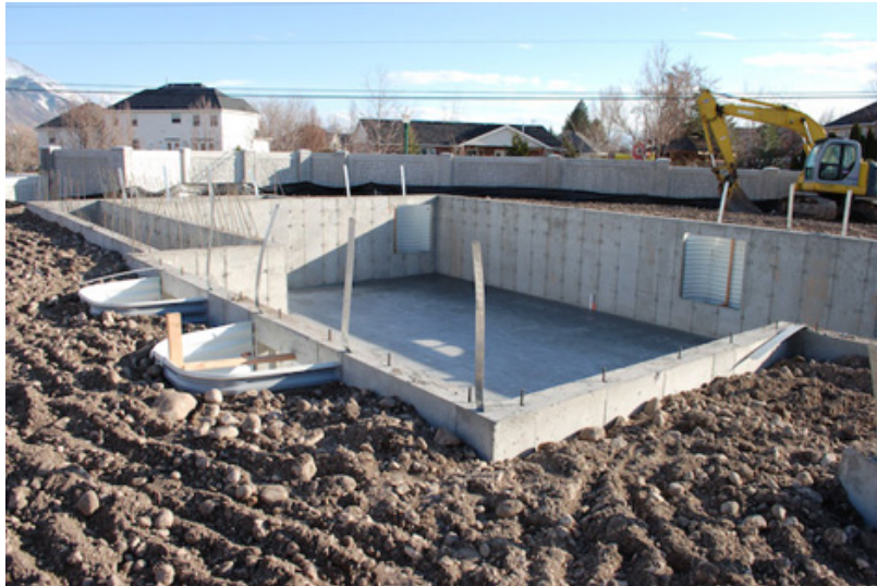
Fig. 4.2.2 Backfilling
