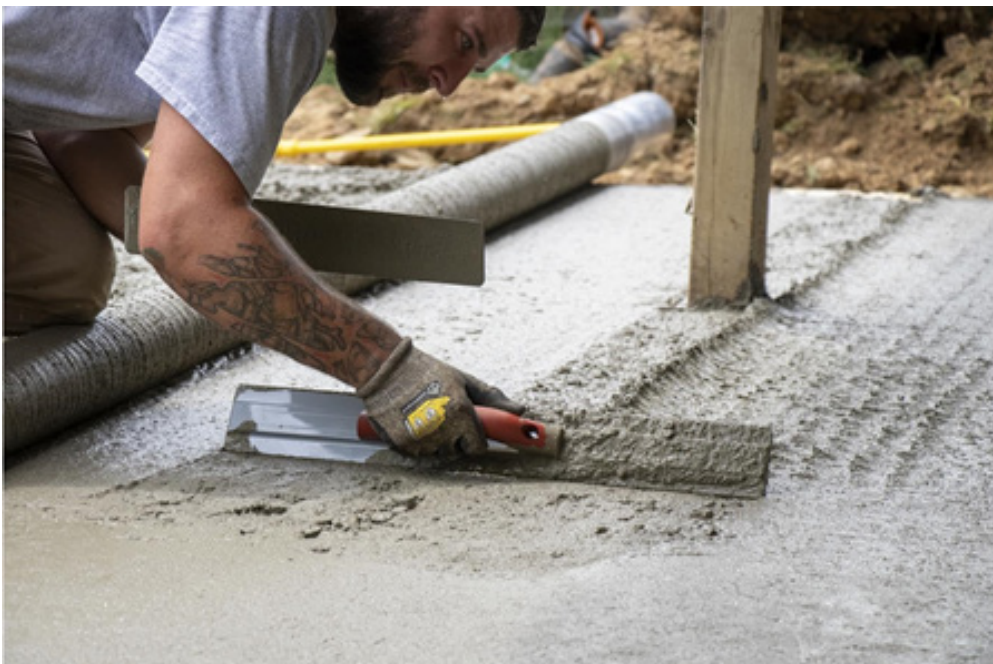
Fig. 3.1.3 Mason using float
