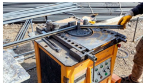
Fig. 1.2.11 Bar bending
