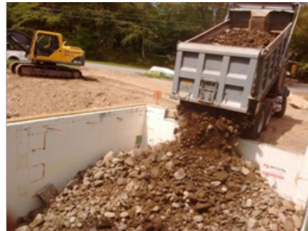
Fig. 4.1.2 Back filling
