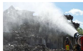
Fig. 7.3.10 Wetting Down Dust
