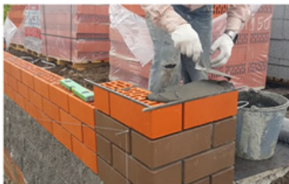
Fig. 6.1.1 Laying mortar
