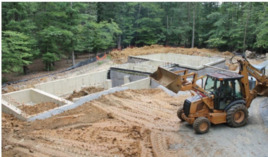
Fig. 4.2.1 Backfilling
