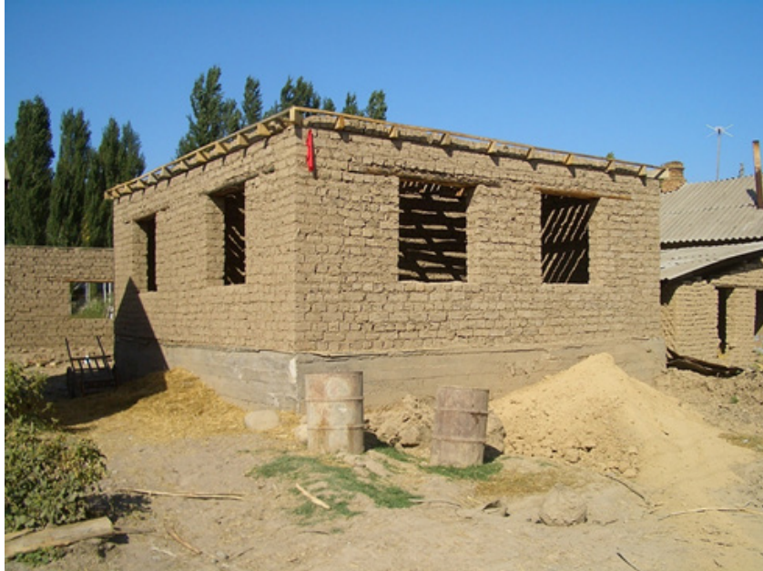
Fig. 1.3.4 Adobe masonry
