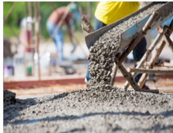
Fig. 1.3.6 Pouring Concrete
