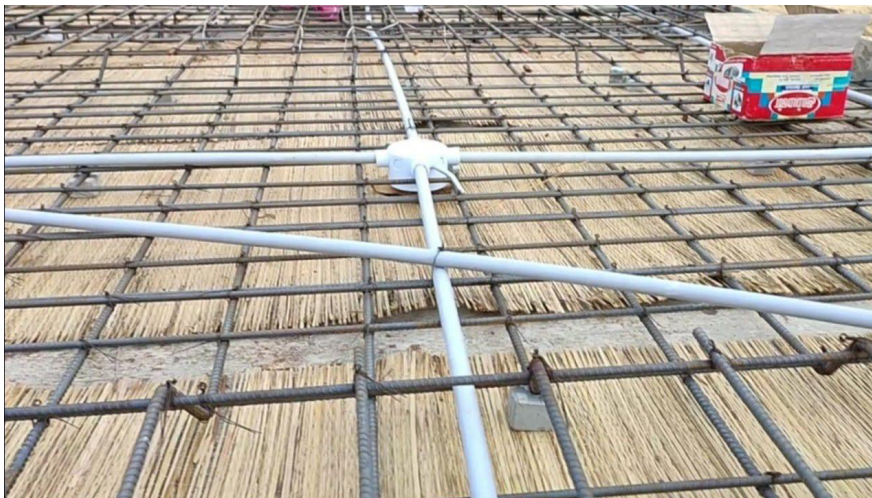
Fig. 3.4.14 Adding Electrical Conduits
