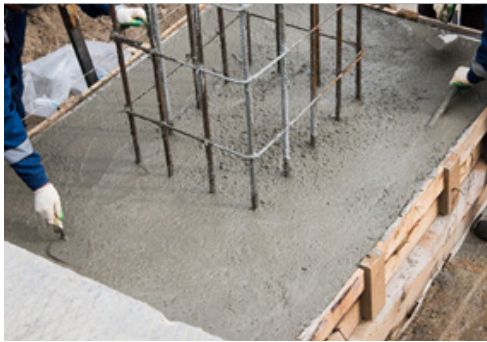
Fig. 3.3.22 Pouring & Compacting
