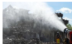
Fig. 8.3.10 Wetting Down Dust
