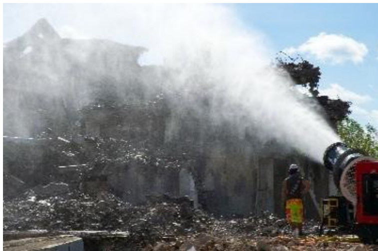
Fig. 7.3.10 Wetting Down Dust
